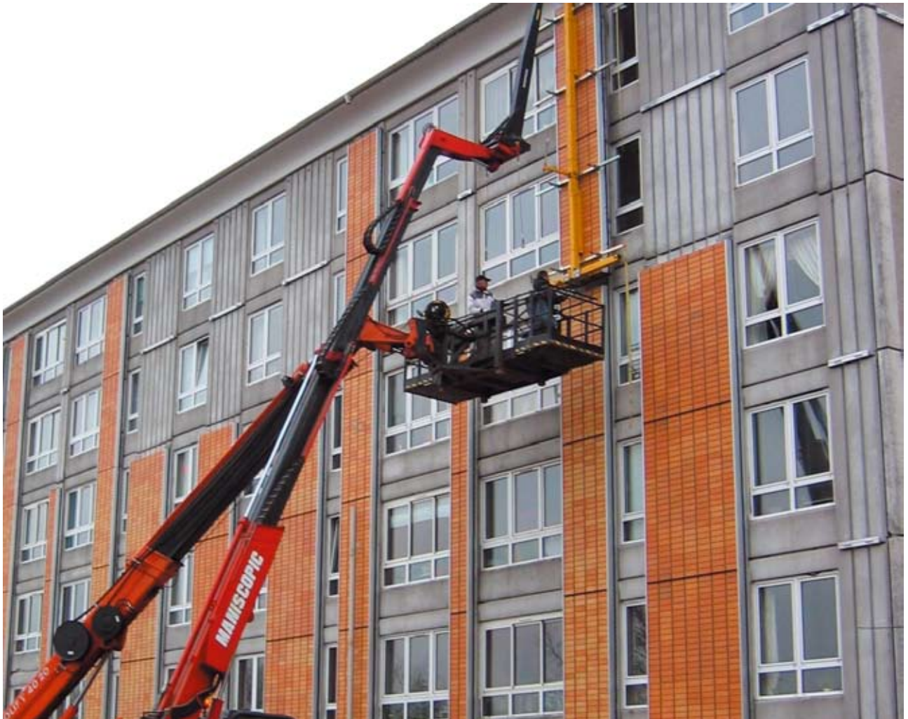
Eksempler på element byggeri.
