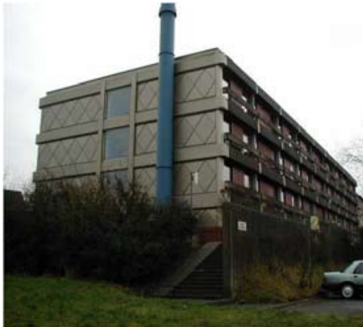
Eksempler på element byggeri.
