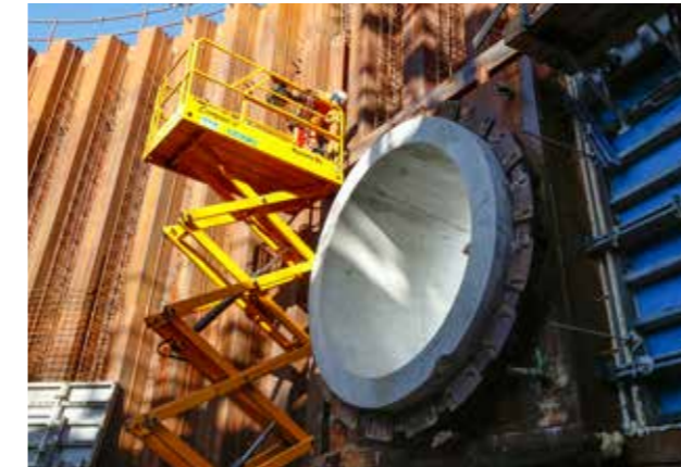
Thames Tideway Tunnel: Etablering af et selvstændigt selskab (Special Purpose Vehicle), der står for etableringen af 20 km suplerkloak under London. Anlægget til cirka 40 mia. kr. vil blive 100 % eksternt finansieret med tilbagebetaling over vandregningen. På billedet ses tunnelarbejde ved Marselisborg Ressourceanlæg
