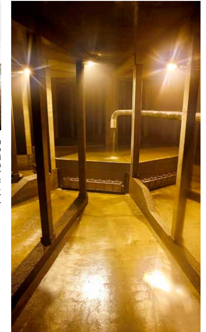
Marquette Lez Lille: Et eksempel på et totaloverdækket renselanlæg, hvor der er investeret i lugtrensning og ventilering. Det er dog en dyr og energikrævende ventilering, så anlægget er ikke energineutralt. Billedet er fra en af Aarhus Vands faciliteter
