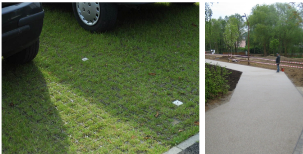
Figur 37: Eksempler på permeable belægninger, som tillader regnvandet at sive igennem. Foto: Byggros
