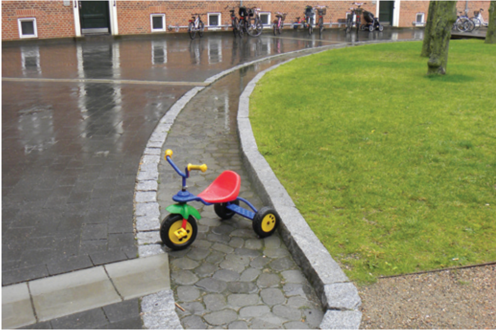
Figur 18: Anlægget i den lukkede gård set tæt på. Det bemærkes hvordan vandet ledes fra ejendommens tagrender ind mod det centrale grønne område og de permeable belægninger. Foto: Smith Innovation
