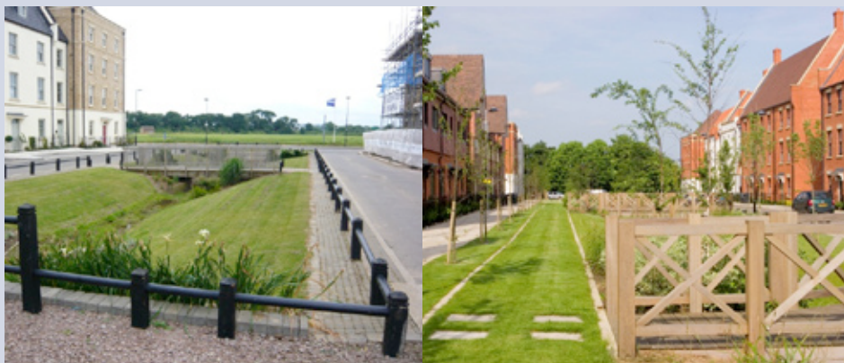
Figur 9: Upton i Northampton, England, har fået et landskabsbaseret dræningssystem efter tidligere at have haft udfordringer med oversvømmelser. Foto: hertslink.org
