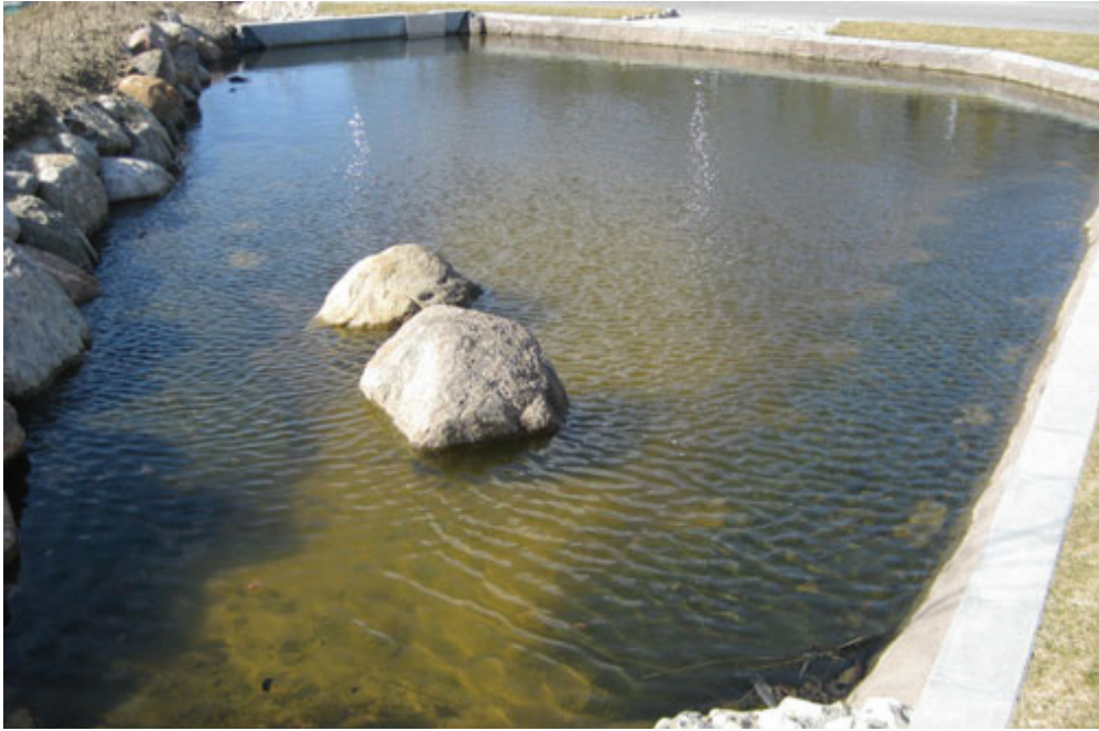
Figur 19: Regnsøen opsamler og synliggør regnvandet, inden det ledes til nedsivning i en faskine. Foto: DANVA Kilde: Klimatilpasning.dk 52
