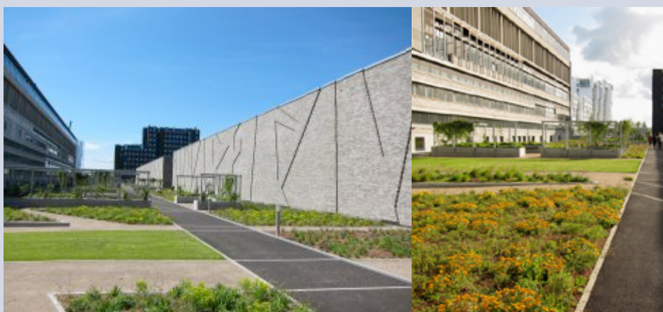
Figur 8: Billeder af Rigsarkivets grønne tag, som er udført og vedligeholdes gennem et OPP-samarbejde.
