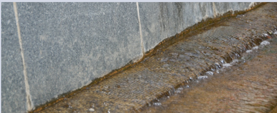
Figur 10: Genbrug af regnvand. Foto: Smith Innovation
