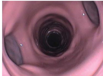
Billeder: Før og efter relining med harpiks.
