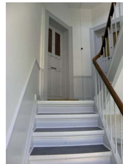
Ejendommene skal være tilgængelige – både for barnevogne, og de der ikke kan gå på trapper.
