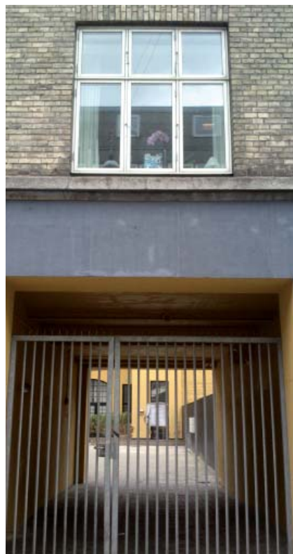
Ved portene ind til gården og under vinduerne er der behov for at efterisolere.
