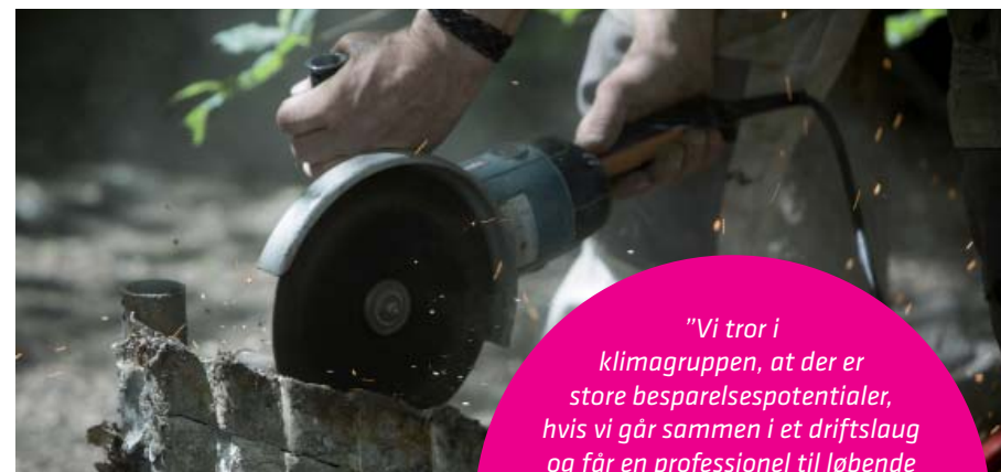
Optimering af varmeanlæggene kan spare energi, og beboerne er interesserede i at gå sammen om driftsopgaver.
