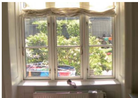
Ved portene ind til gården og under vinduerne er der behov for at efterisolere.
